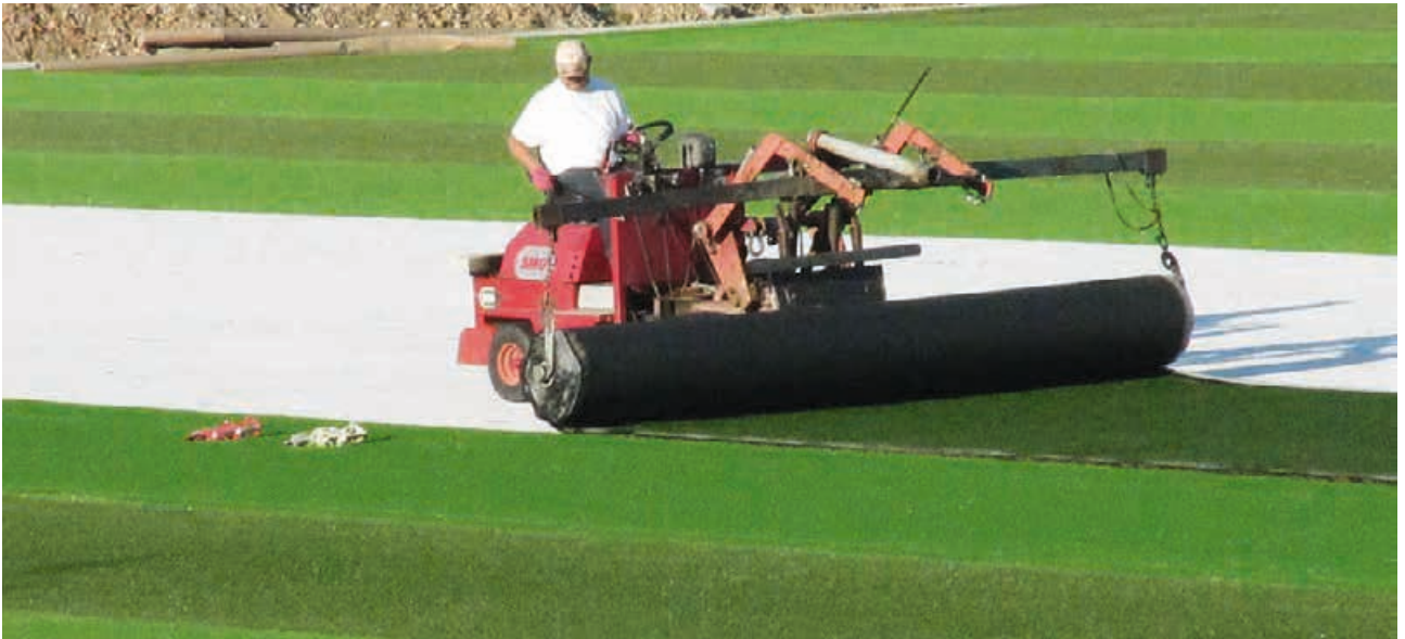
Spezialmaschine verlegt eine Kunstrasenbahn.
